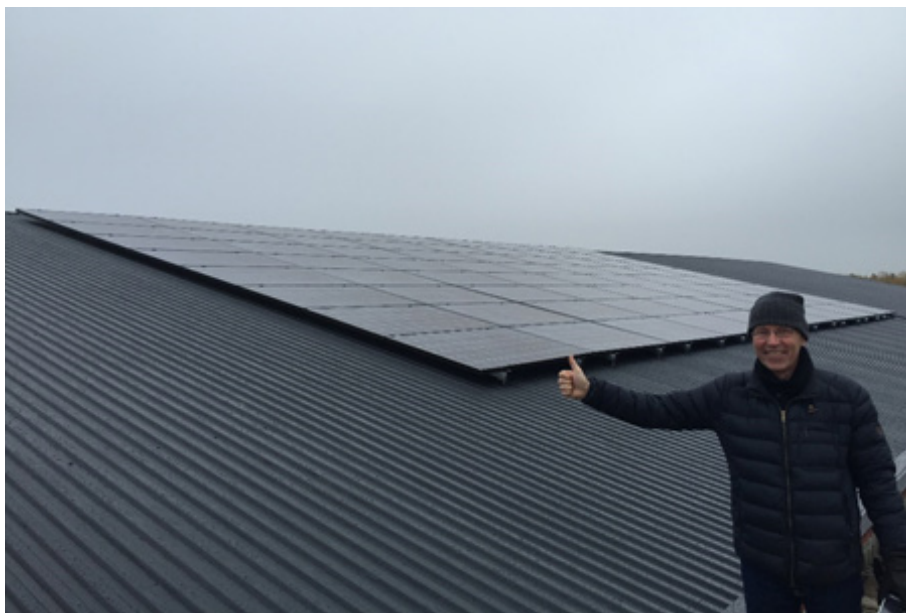
Magnus Källmark, Egendomsavdelningen, är i Alnarp och installerar solpaneler.
