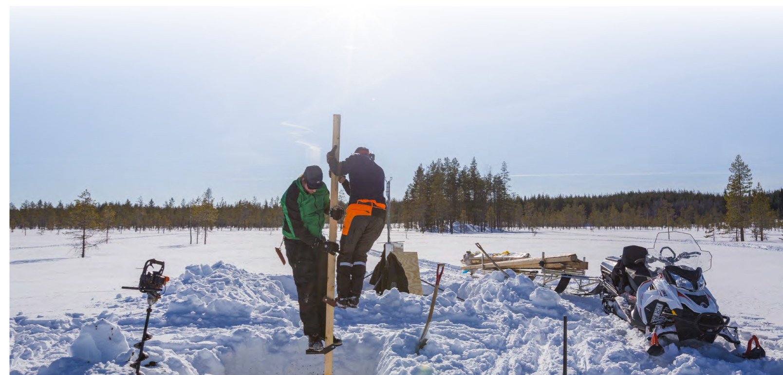
SLU-forskare driver ner pålverk i myren för att kunna förankra en fluxmast för mätningar av växthusgaser. Foto: Andreas Palmén
